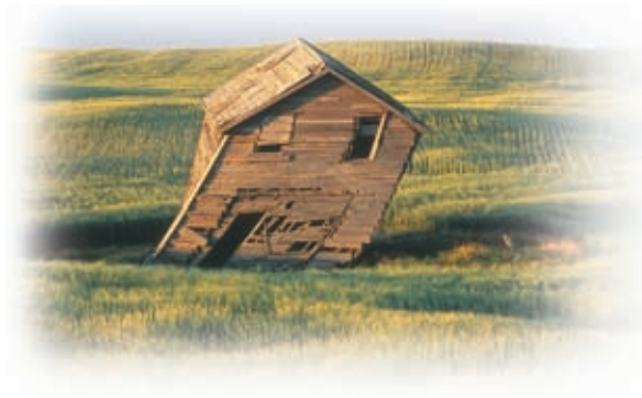
Figure 5.14 Cette vieille maison montre des signes de fatigue structurale. Cependant, il faudra encore quelques tempêtes pour qu'elle défaille entièrement.
